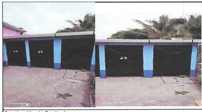
Sustitución de Sanitario.
