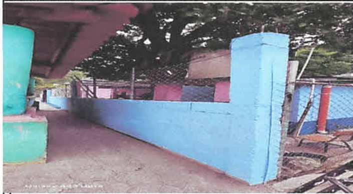
Levantado de muro perimetral.
