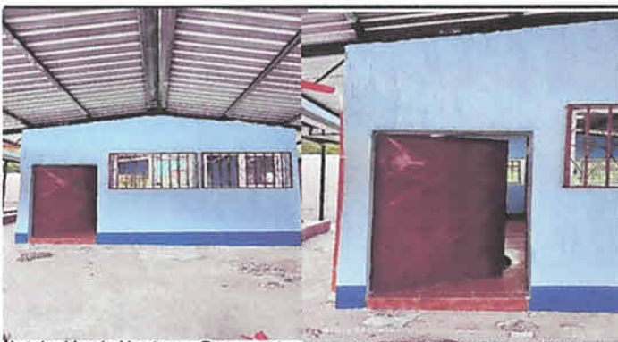
Intalación de Ventanas Pvc, mantenimiento a puerta, pintura en muros interiores y exteriores.
