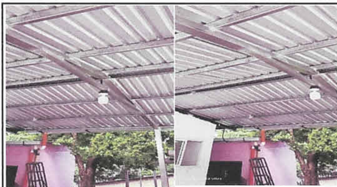
Construcción de Galería.
